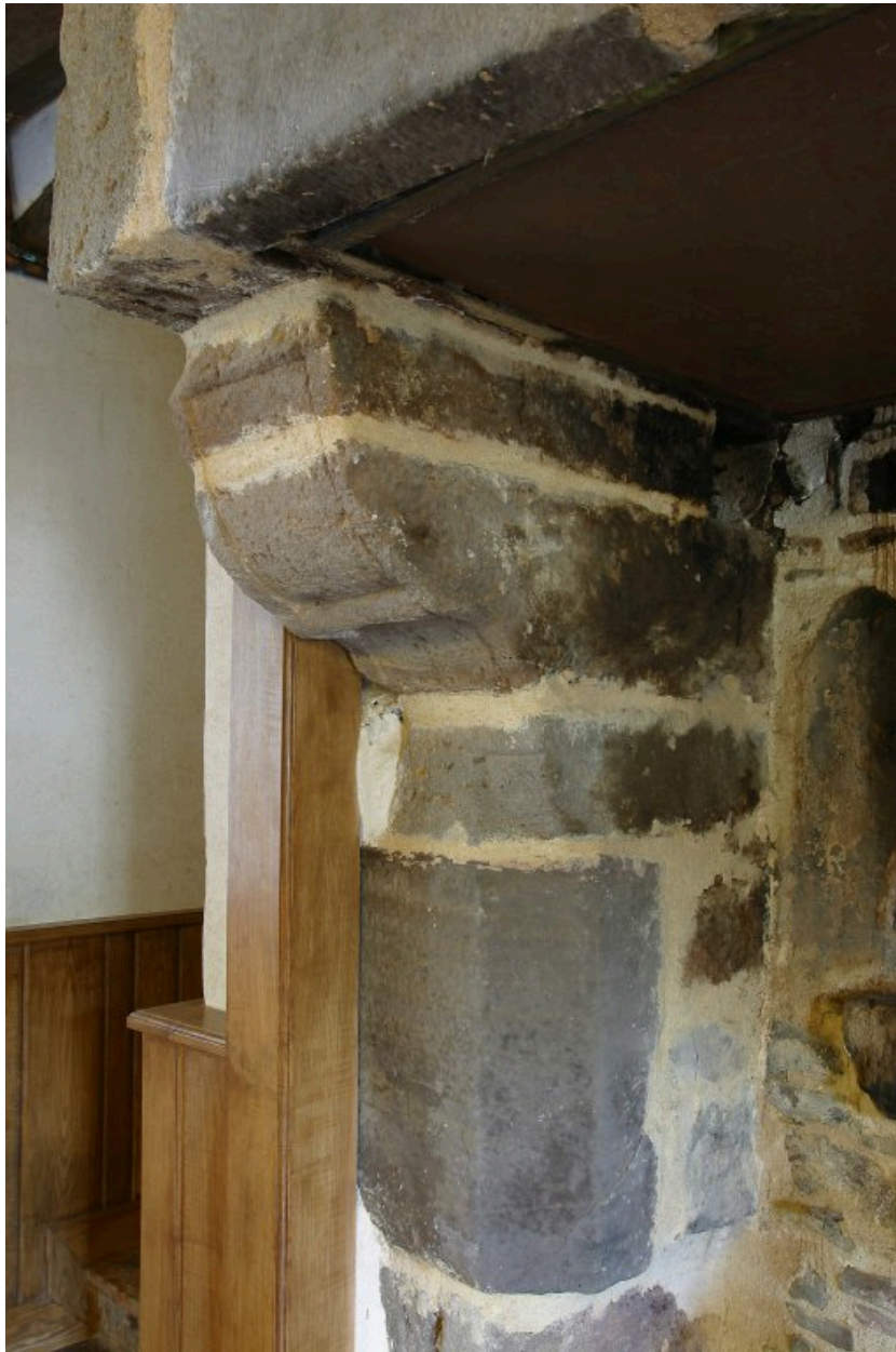
Détail de la cheminée : piédroit et corbeau de gauche.
