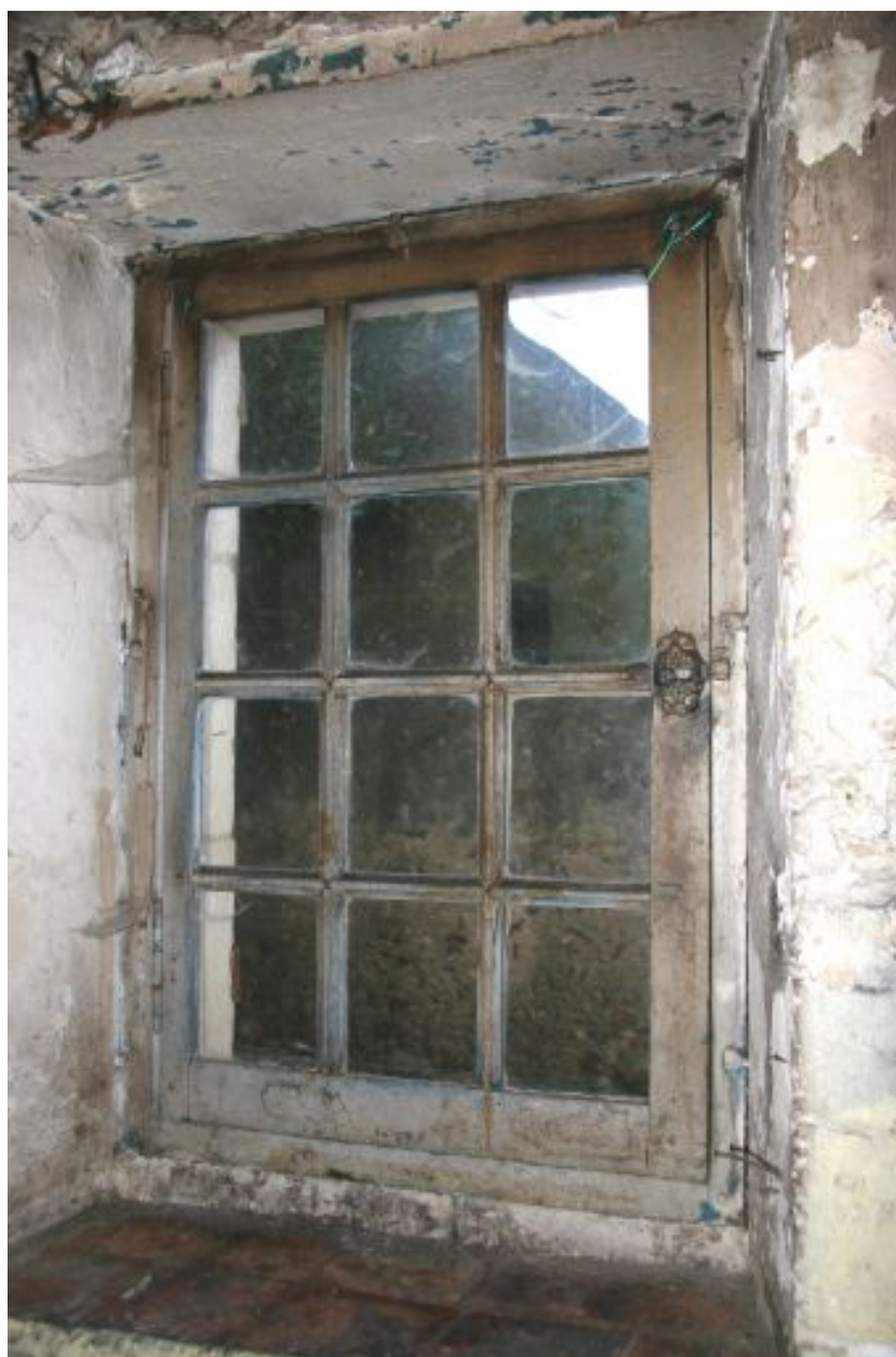
Maison au fond de la cour : menuiserie de la baie.
