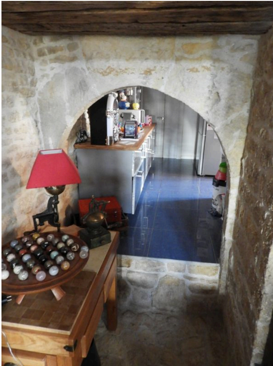
Porte en arc en plein cintre au rez-de-chaussée, ancienne descente de cave.
