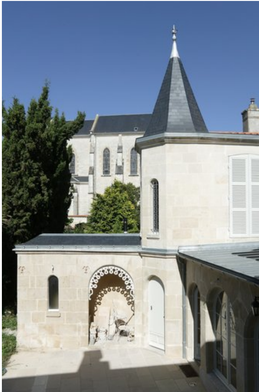
Vue du pavillon est. Au fond, la chapelle du carmel.
