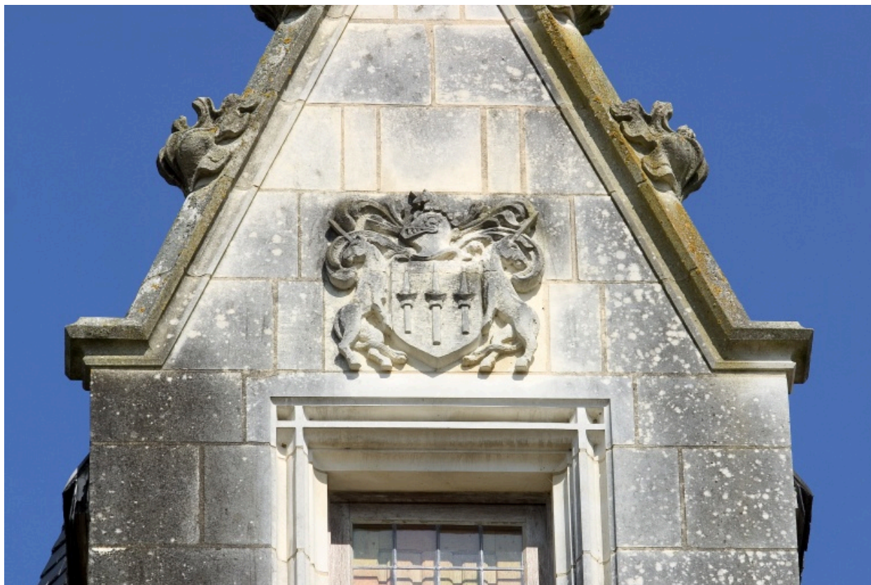
La lucarne de la tour : détail.
