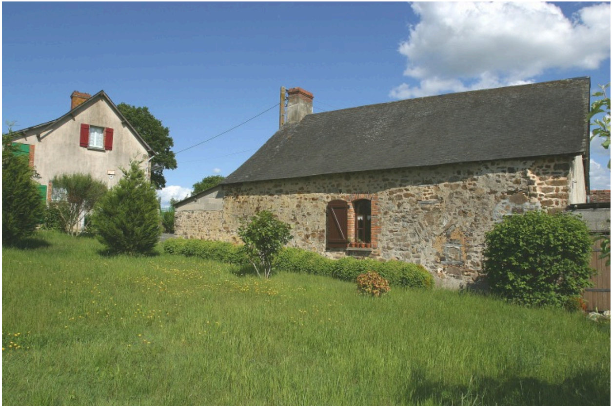
L'ancien logis-étable vu depuis l'ouest : façade arrière. A gauche, le pignon du logis moderne.
