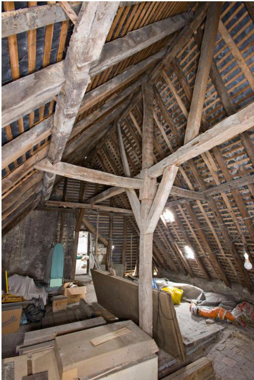
Maison en pan-de-bois : charpente à panne avec sous-faîtage bas et faux entrain à encoches.
