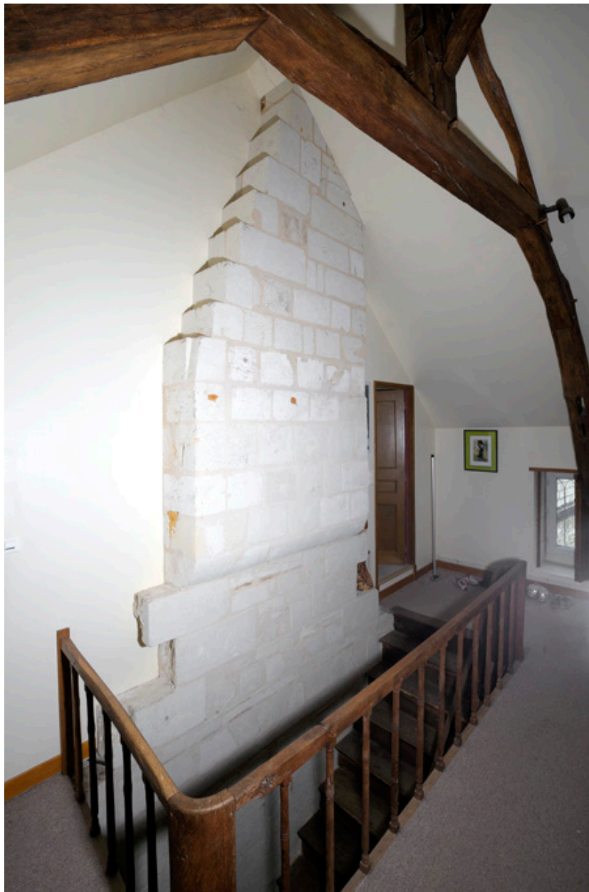
Vue du massif de maçonnerie abritant les conduits de cheminées, dans le comble.
