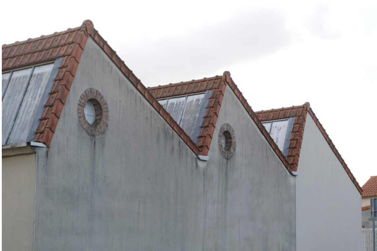
Détail des sheds.
