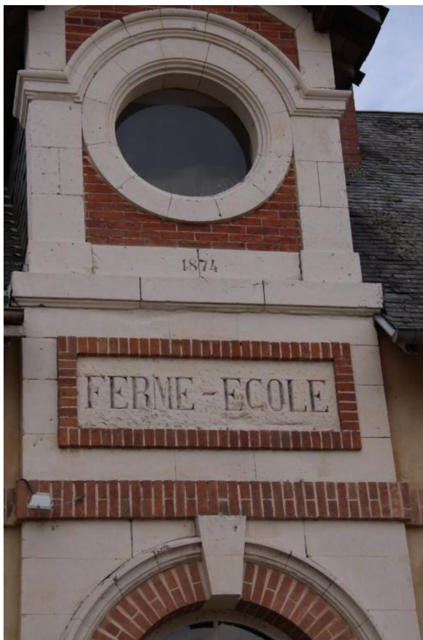
Ferme-école, façade principale : détail de la travée centrale (1874).
