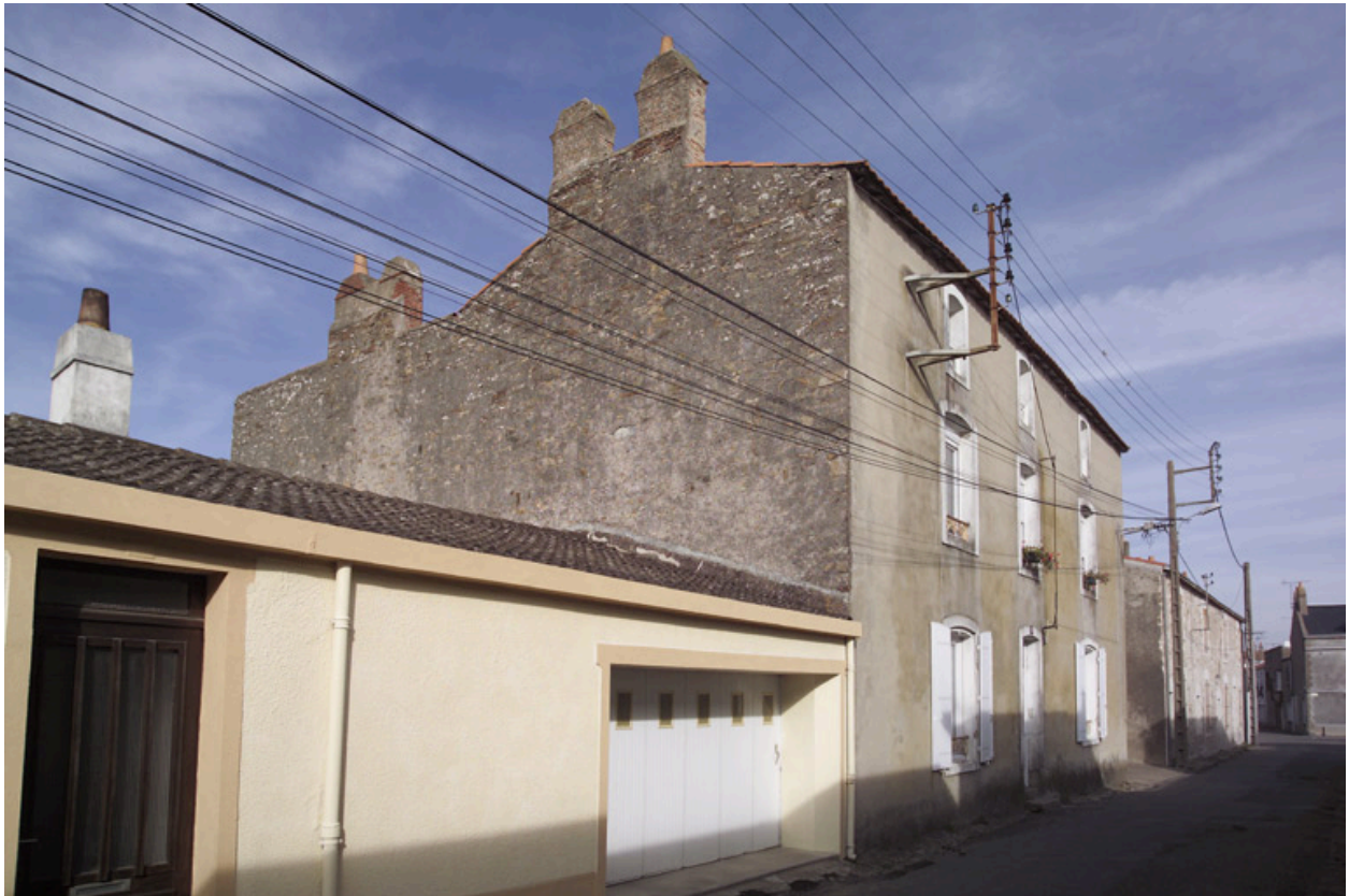
Vue de la façade depuis la rue.
