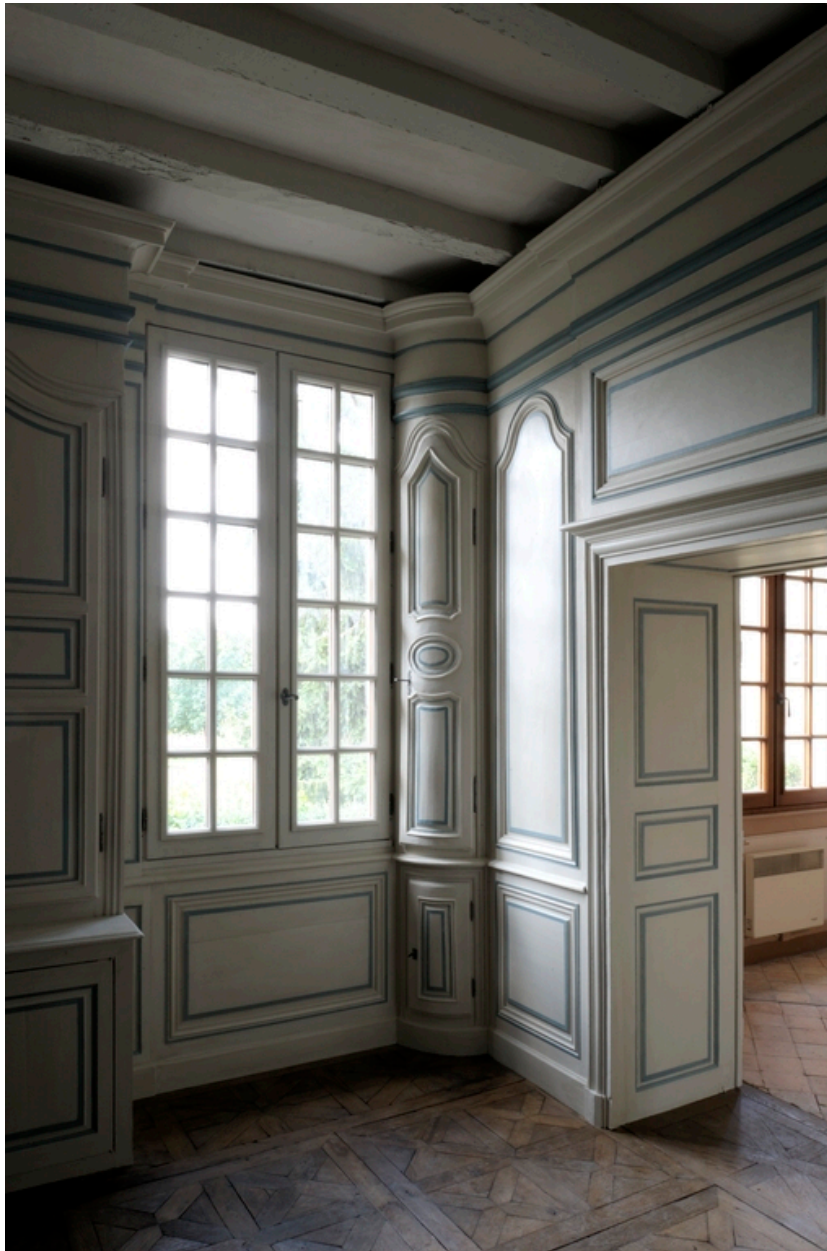
Etage, salle lambrissée. Vue des lambris peints après restauration (2013).
