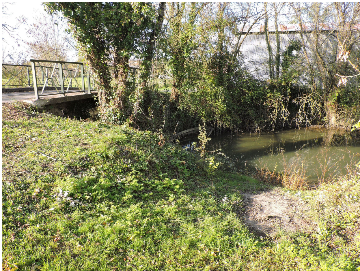
Le pont et l'abreuvoir en amont vus depuis le sud-est.
