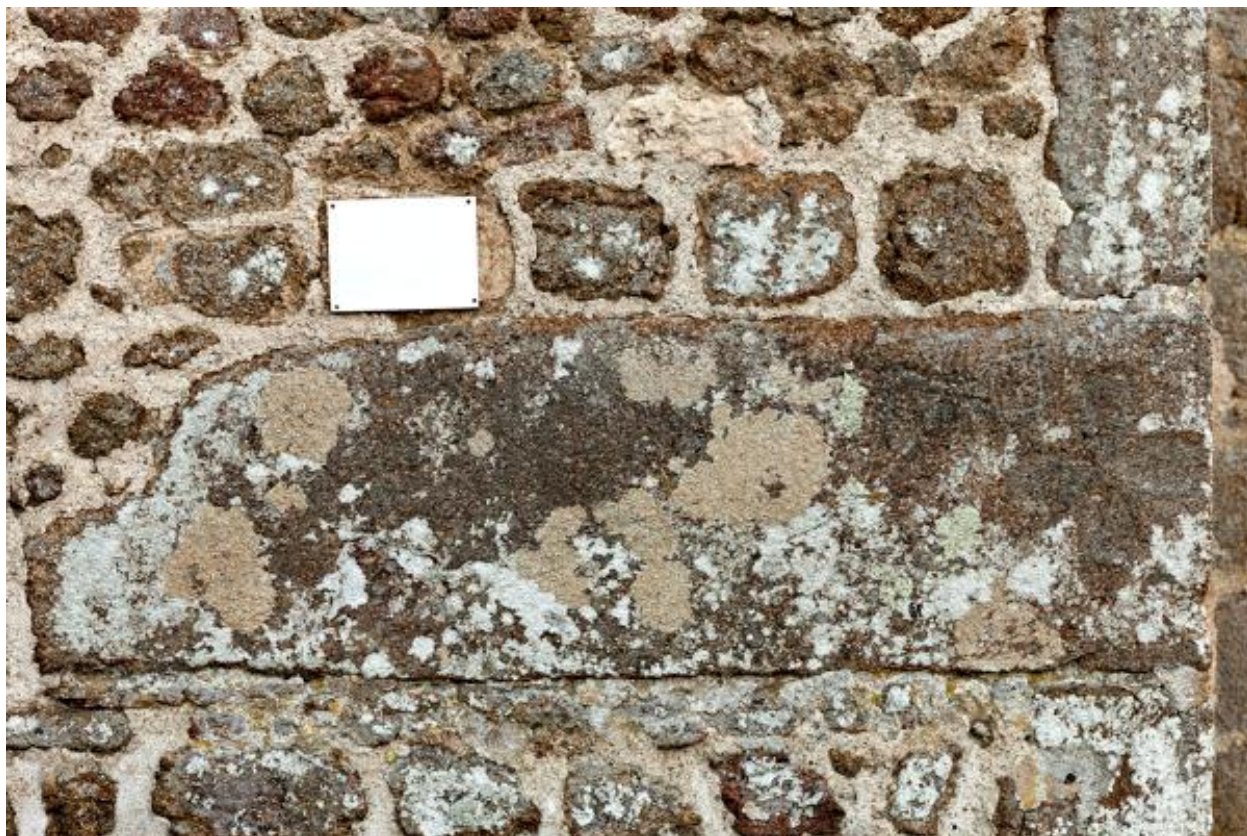
Chaîne d'angle nord-ouest, face nord, remploi de pierres tombales.
