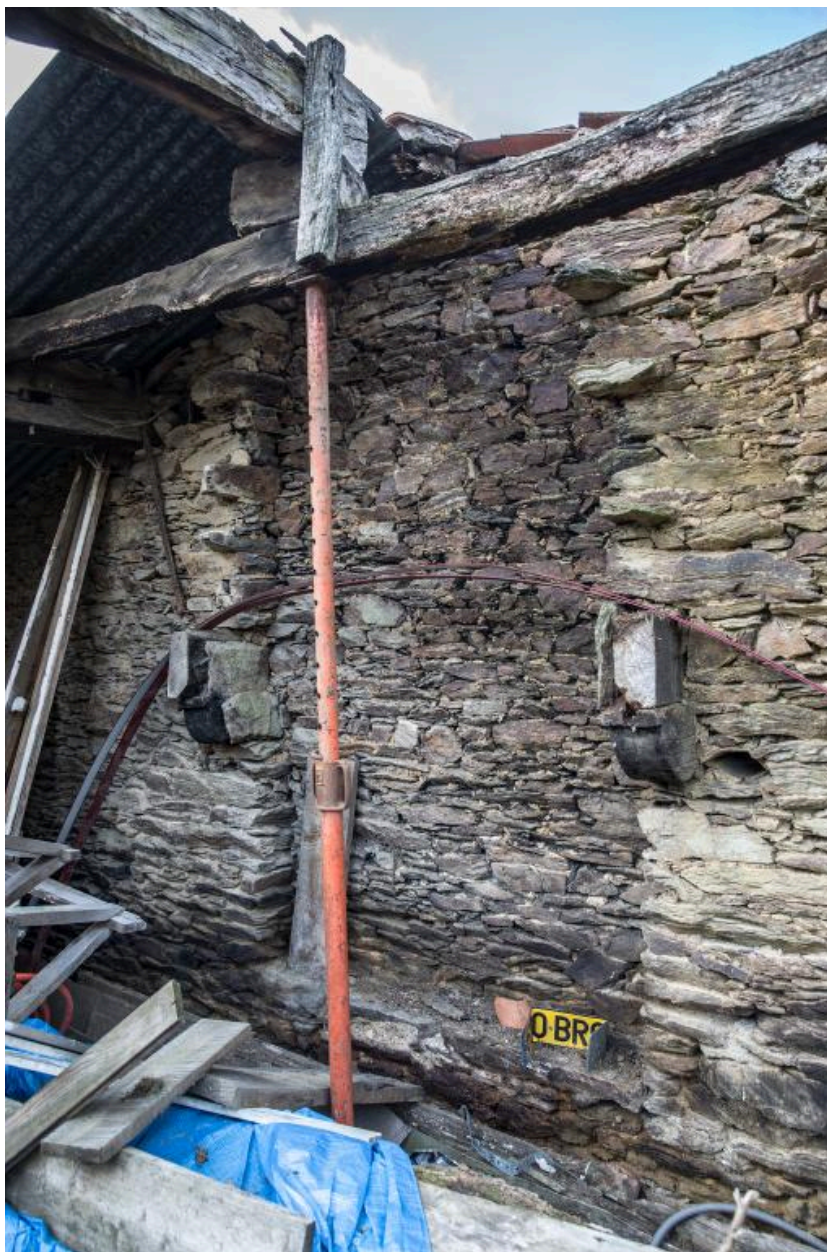
Foyer de cheminée présentant un décroché d'environ 30 cm de profondeur. La Brégonnière, la Boissière-du-Doré, 2018, B 01-278.
