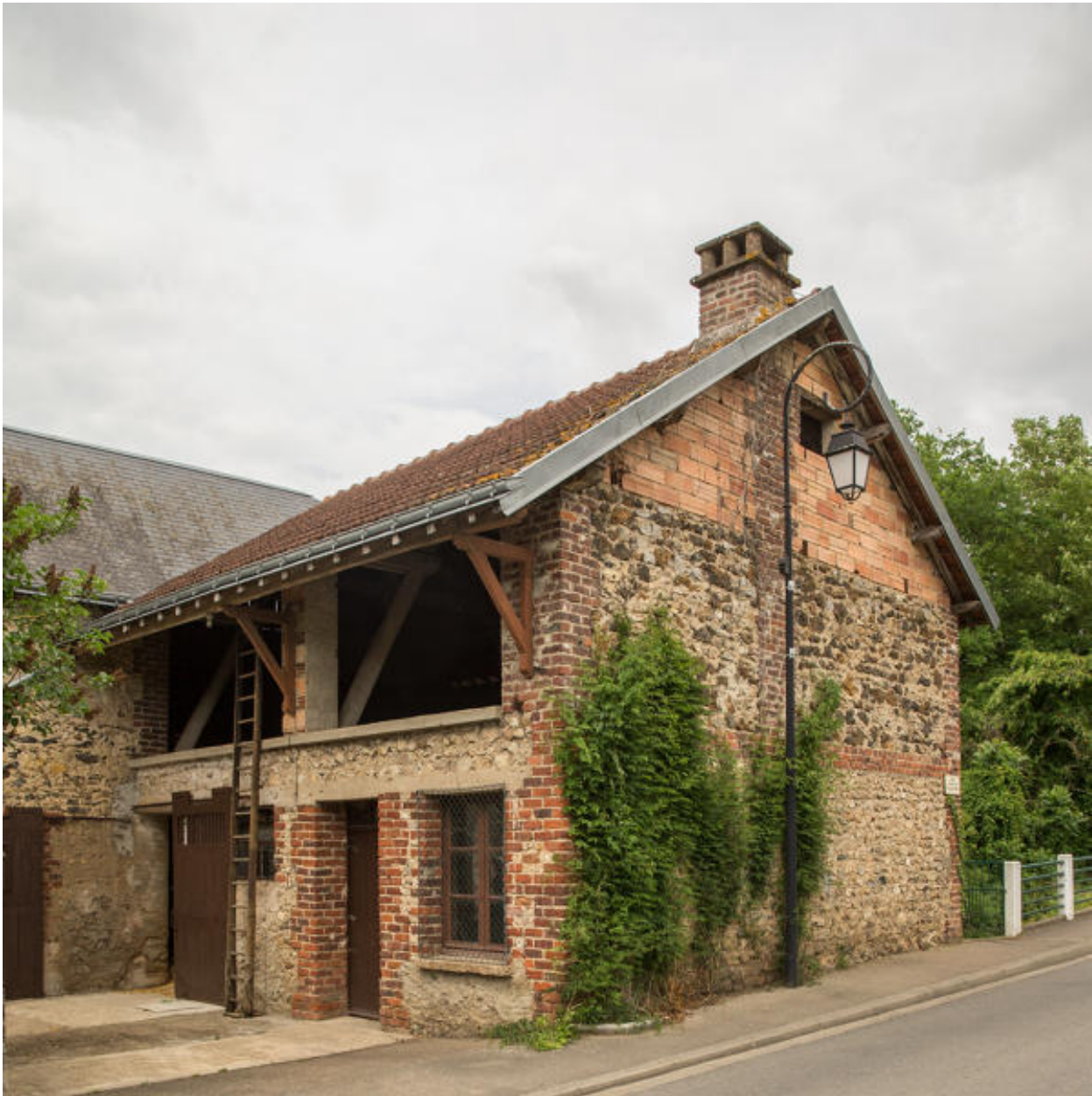
Rue A. de Tocqueville : maison transformée en bâtiment rural.
