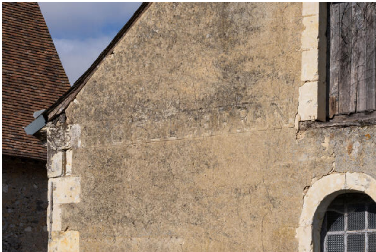
Pignon est, détail de l'inscription : "HOTEL DE FRAN[CE]".
