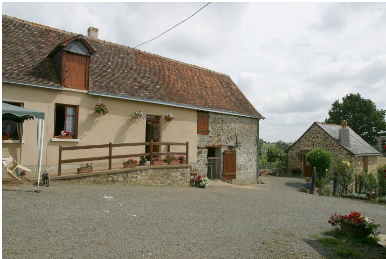
Les bâtiments sud : vue rapprochée depuis le sud-ouest.
