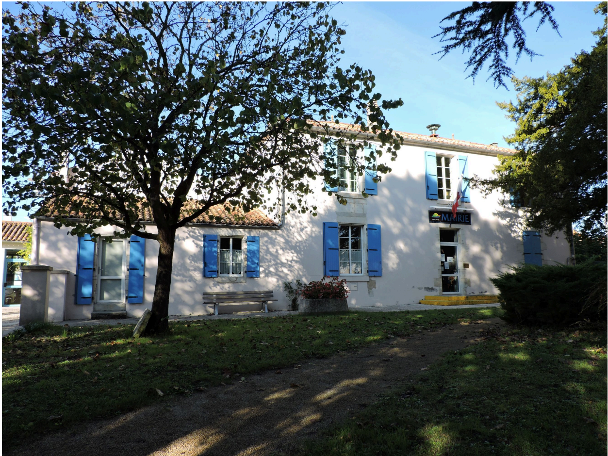
La mairie, ancien presbytère, vue depuis l'est.
