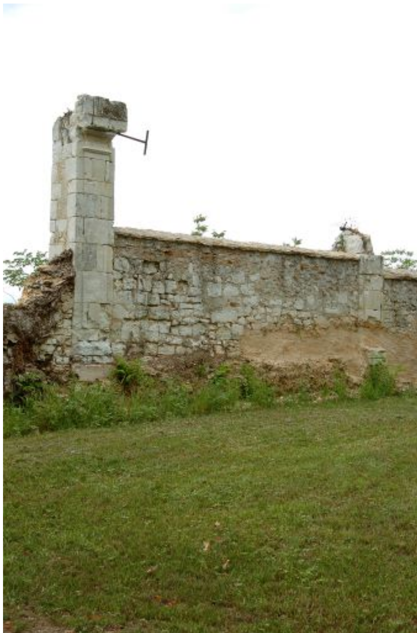
Vestiges d'un pilier du vieux mur de clôture du jardin.
