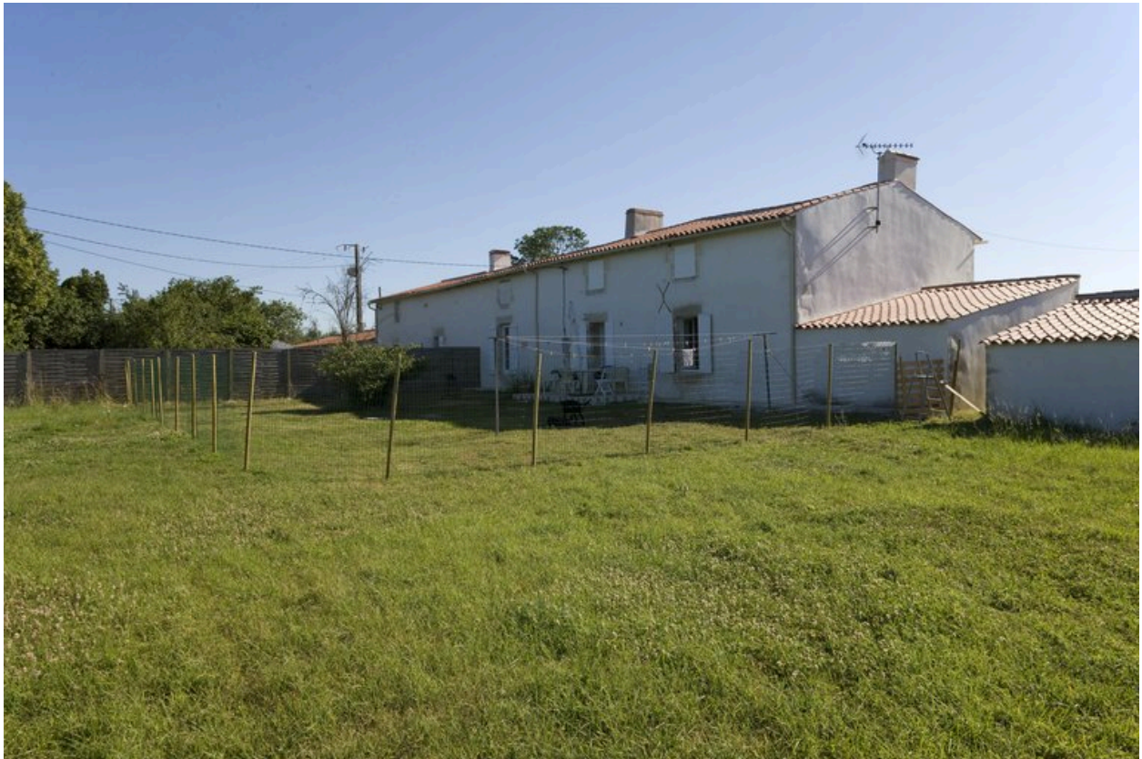
Vue de la maison prise du sud-ouest. A droite, la porcherie.
