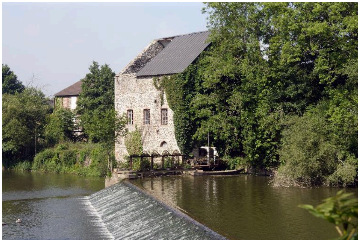
Le moulin à farine vu depuis la rive gauche en amont : élévations est et nord.
