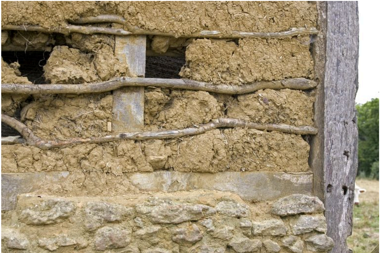
La Pichinière : détail de l'armature du hourdis de torchis.
