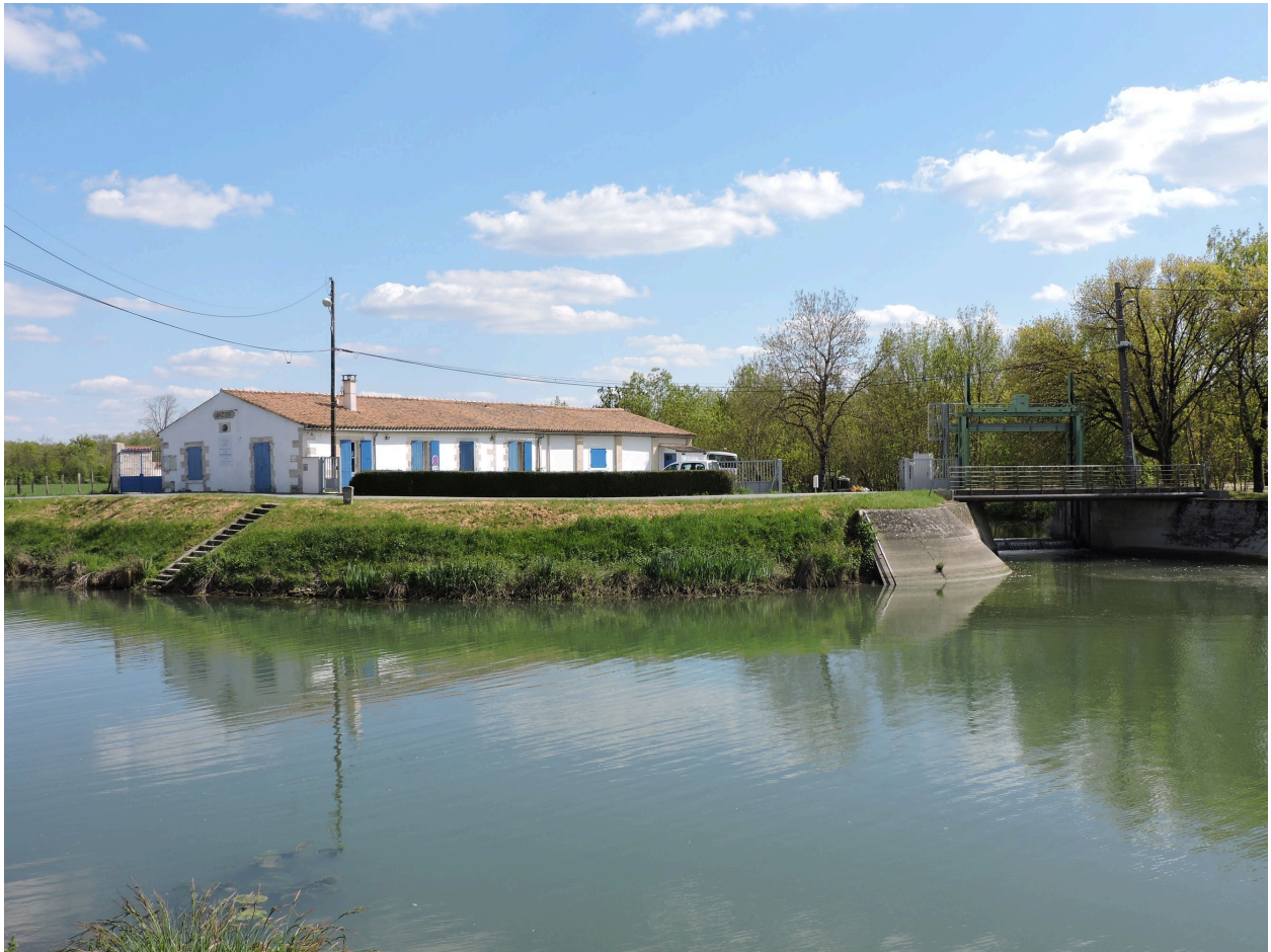
La maison éclusière et le barrage du Vieux Bézou vus depuis le nord-ouest.
