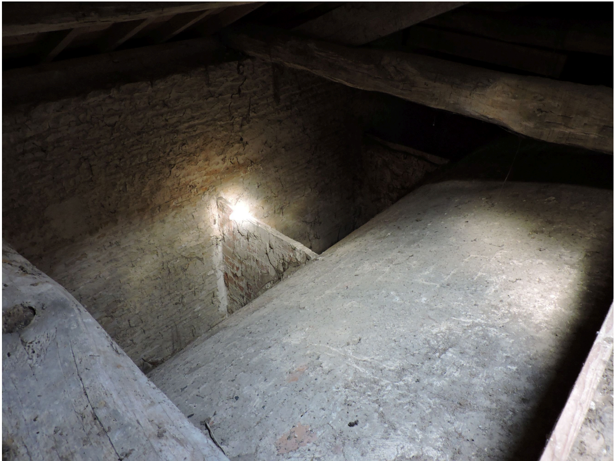
Voûte et mur nord de la nef.
