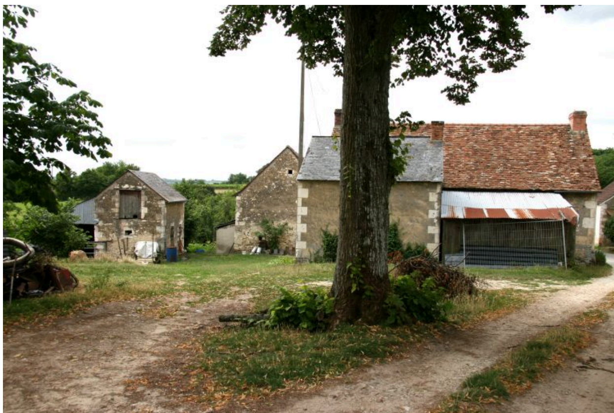
Façade postérieure des bâtiments.
