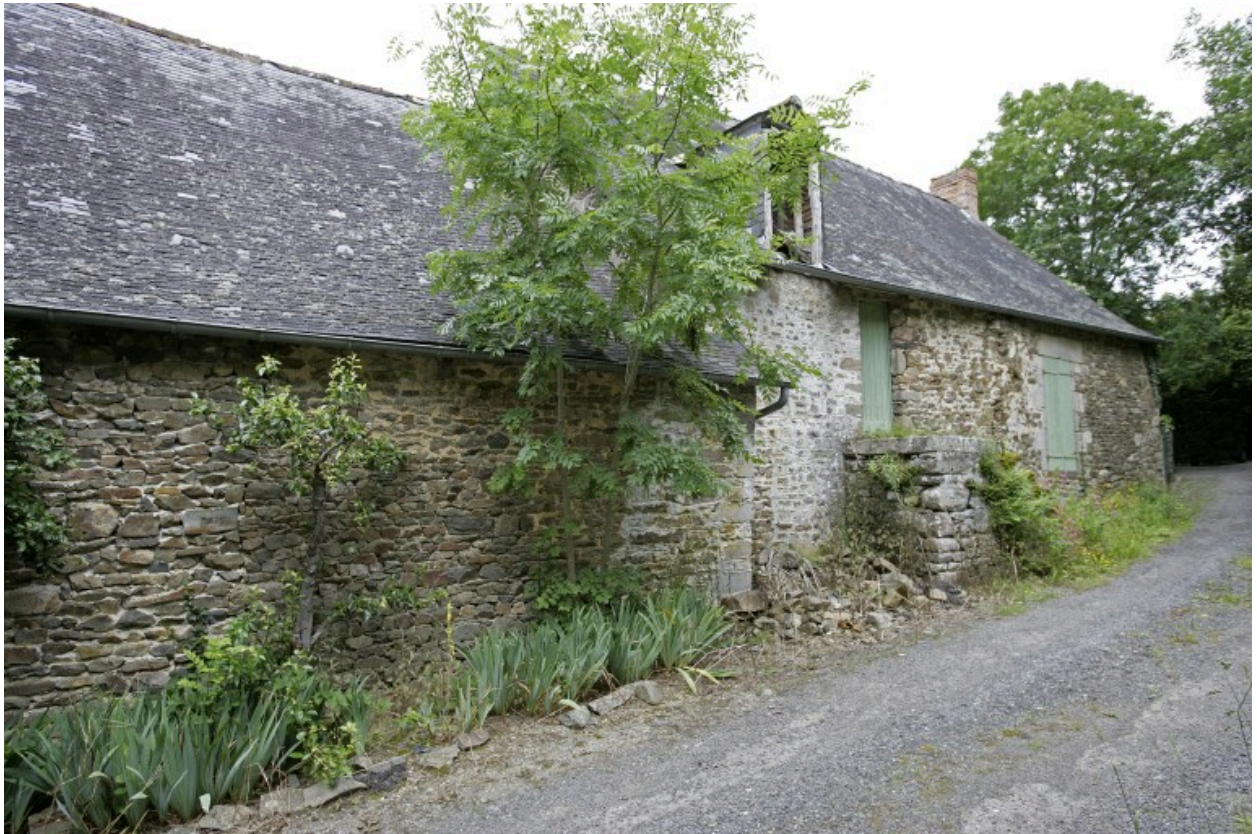
Le logis-dépendance vu depuis le chemin au sud-ouest.
