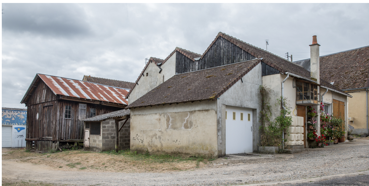
L'ancienne cidrerie Lebec, rue de Belfort.
