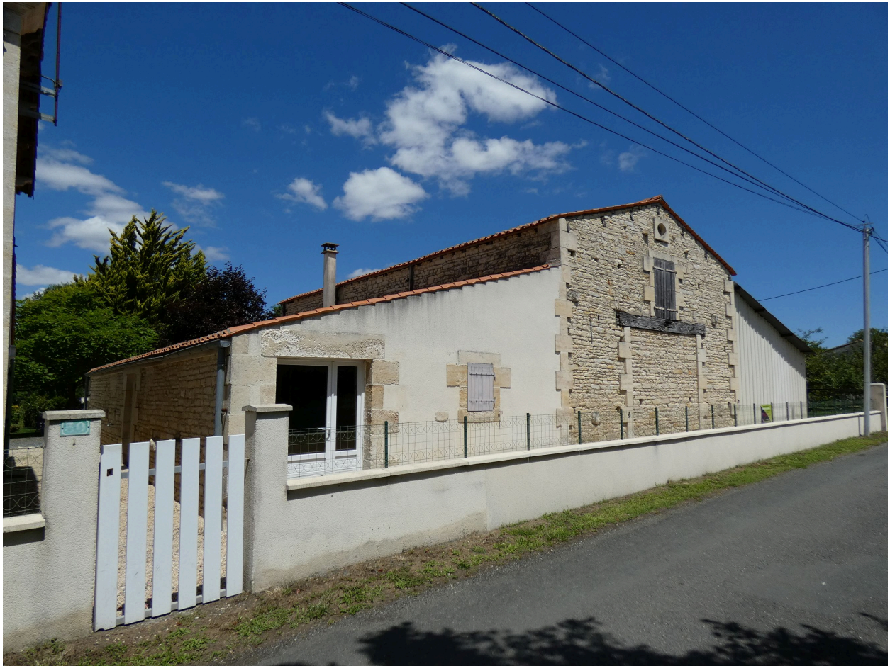
La grange-étable vue depuis le sud-ouest.
