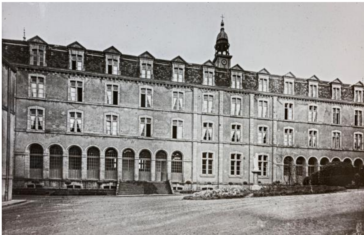
Maison conventuelle des soeurs (bâtiment A).
