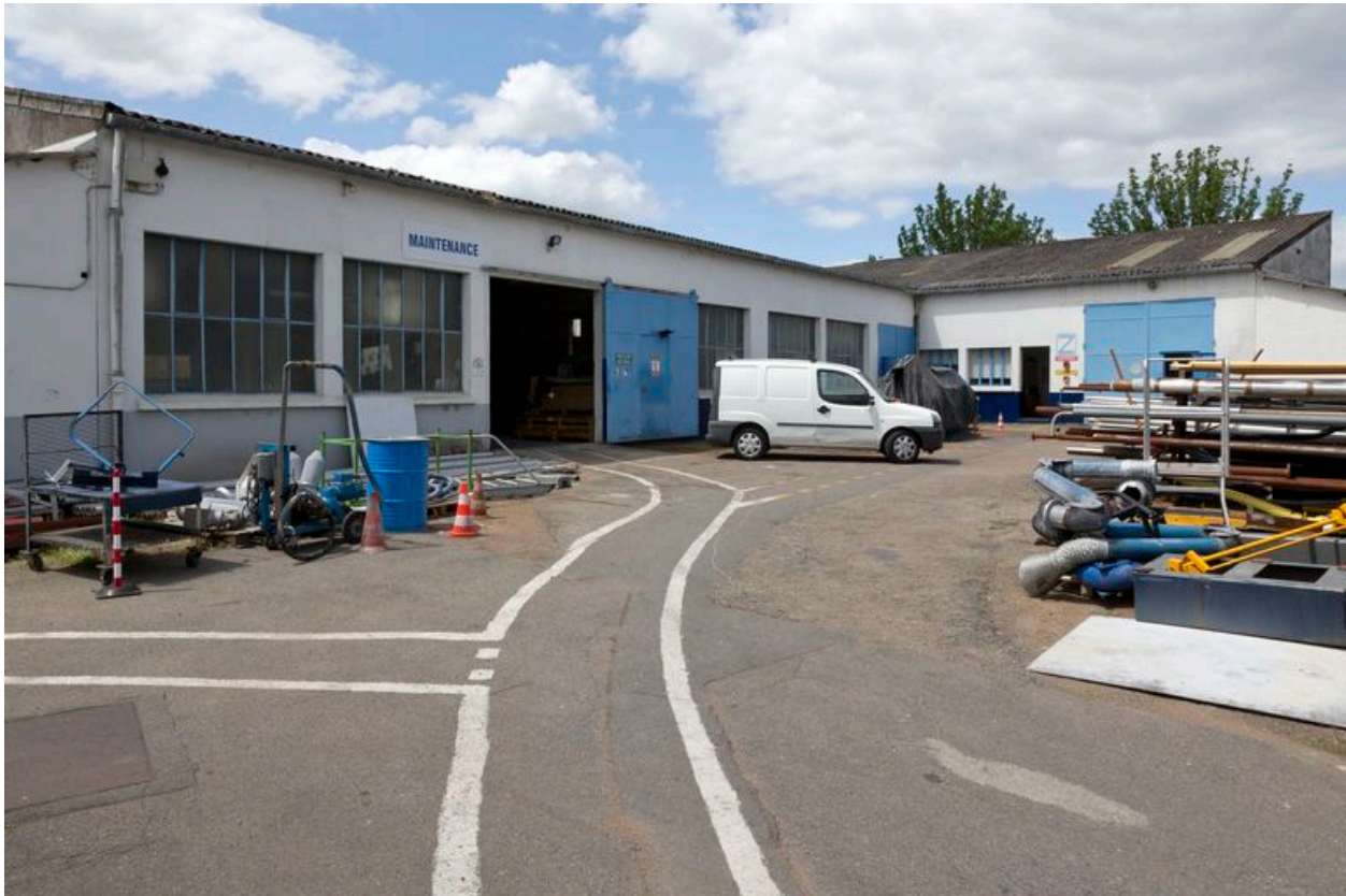
Atelier de maintenance.
