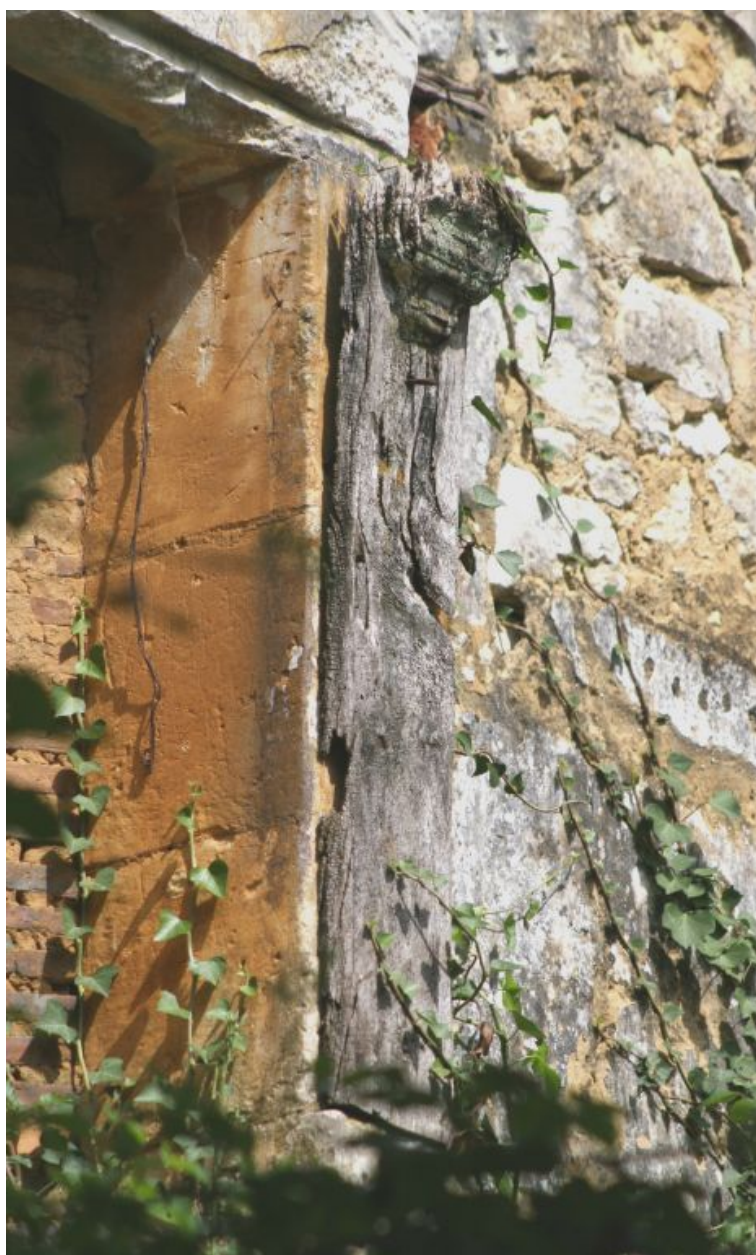
Le logis, 1er étage, chambre centrale : lambris du piédroit.
