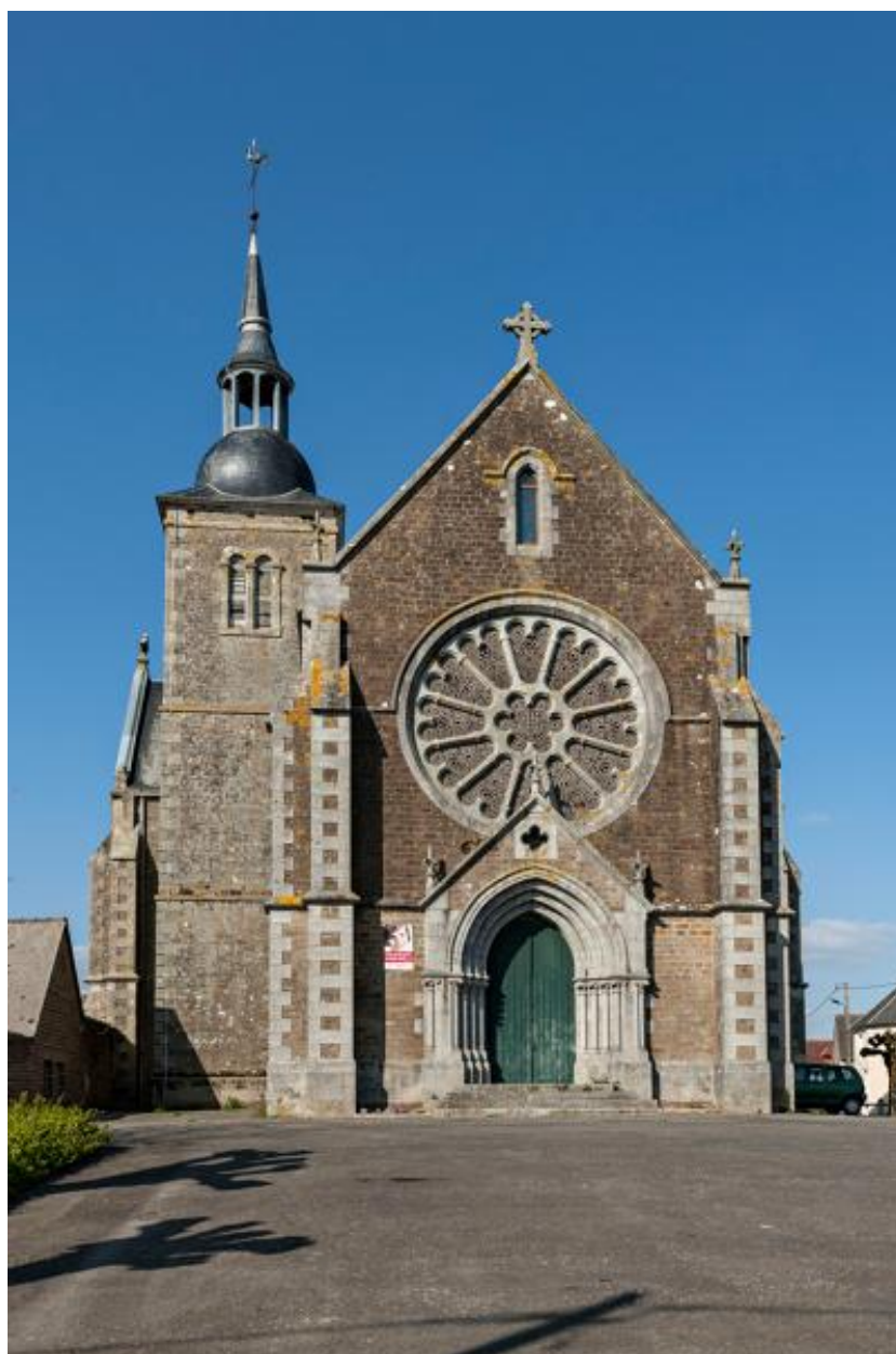
Façade sud de l'église Saint-Hippolyte.
