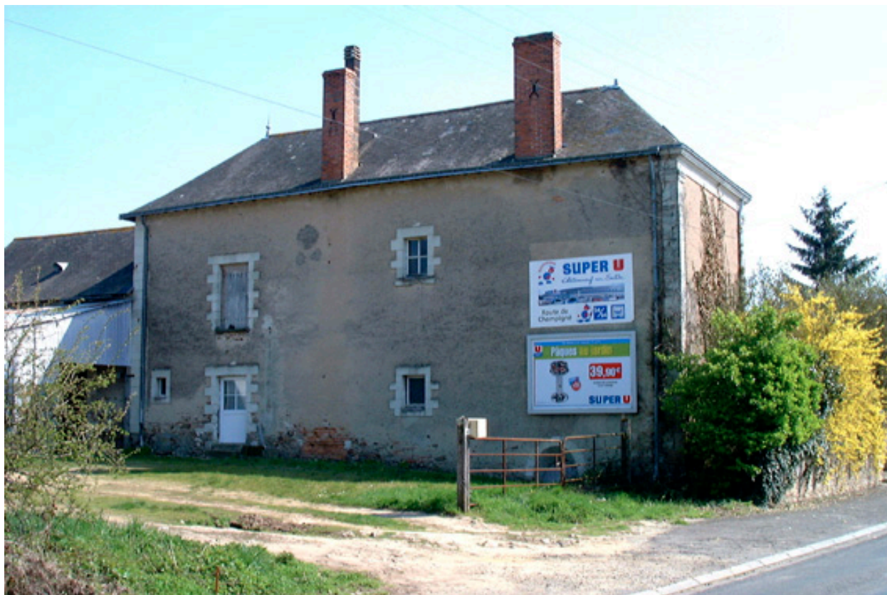
Maison à étage carré : façade postérieure.
