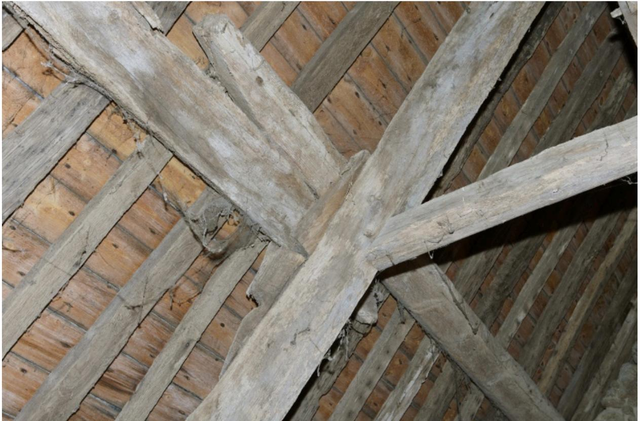
Détail de l'assemblage au niveau de la panne et du chevron-arbalétrier.
