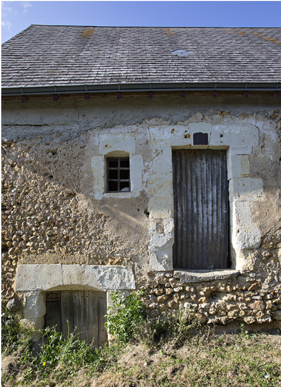
Façade sud, détail : baies (côté gauche).
