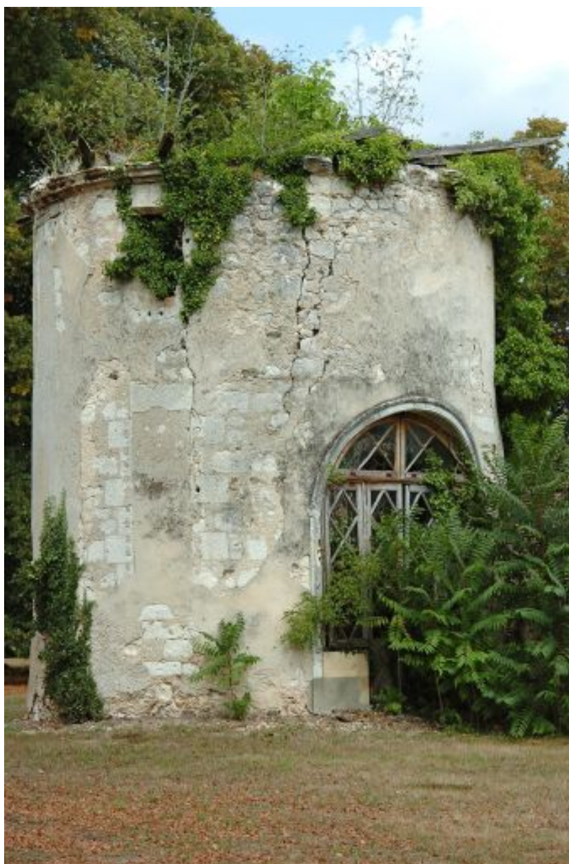
Tour d'angle de l'ancien château transformé en orangerie dans le nouveau château démol.
