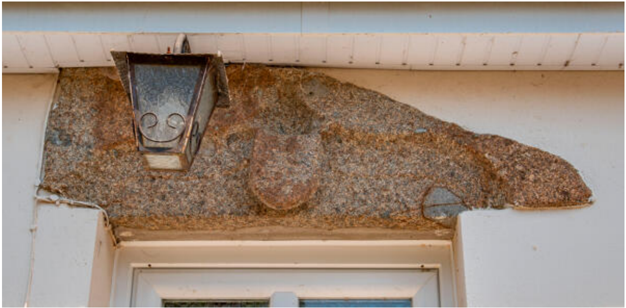
Linteau de porte orné d'une accolade et d'un écu (parcelle ZD 59).
