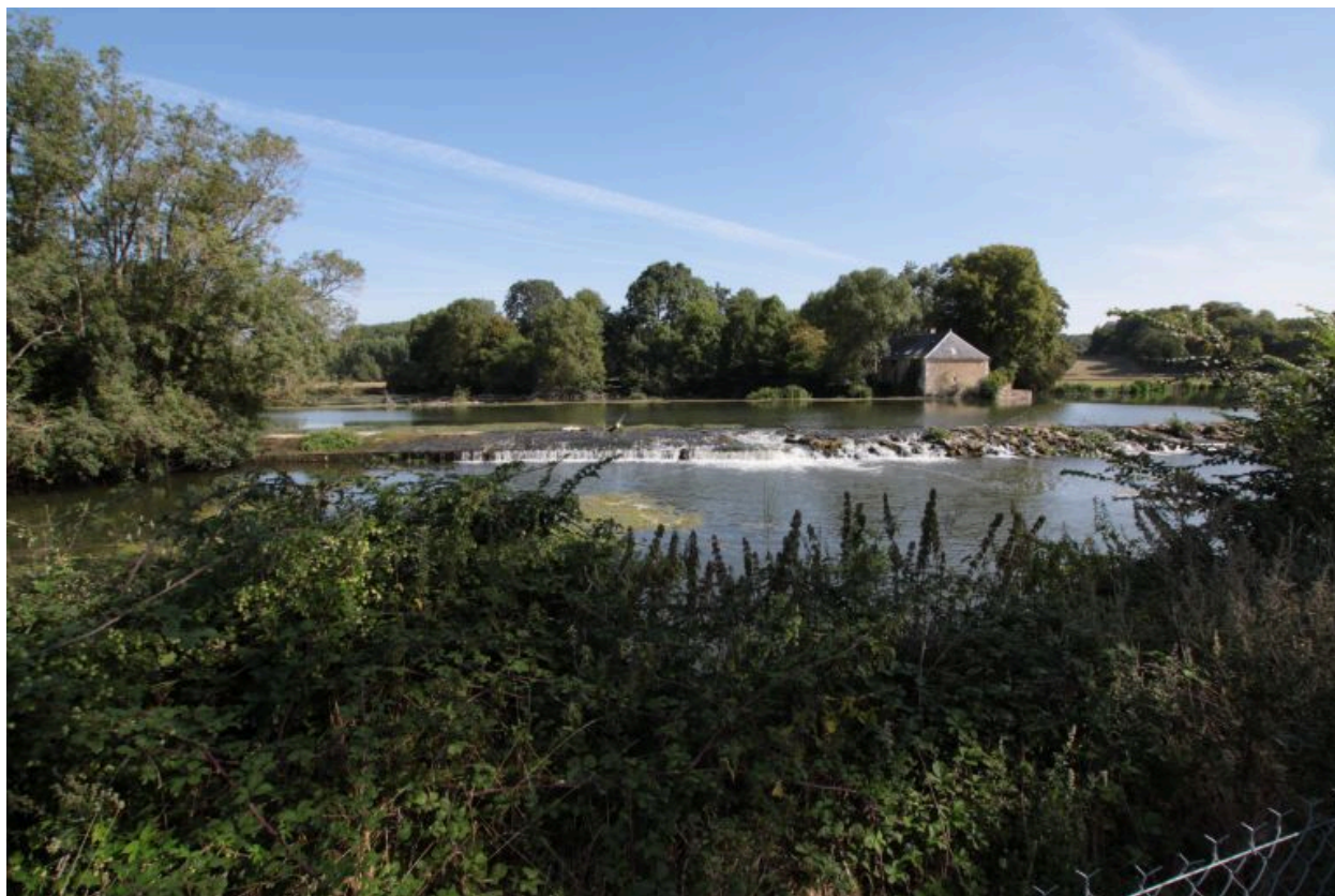
Le barrage sur le Loir.
