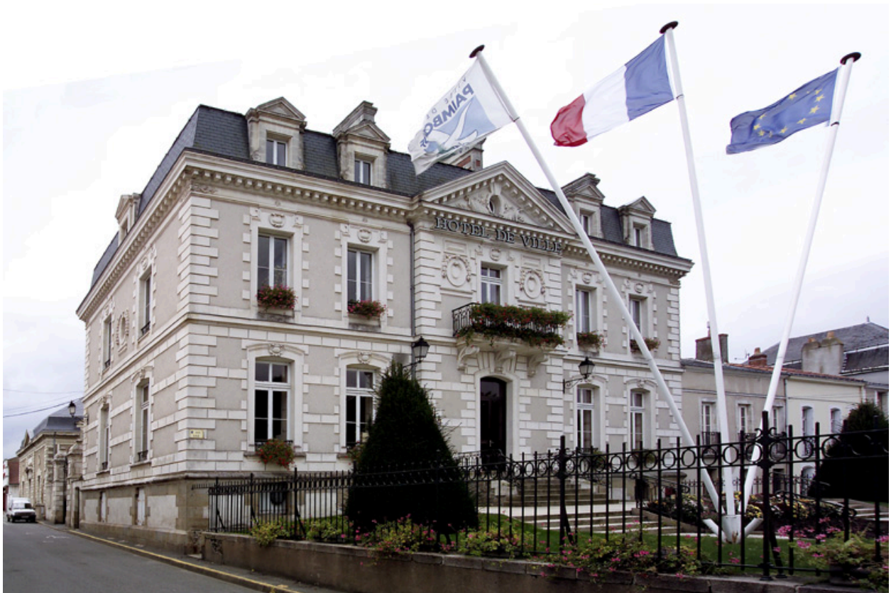
La façade nord.
