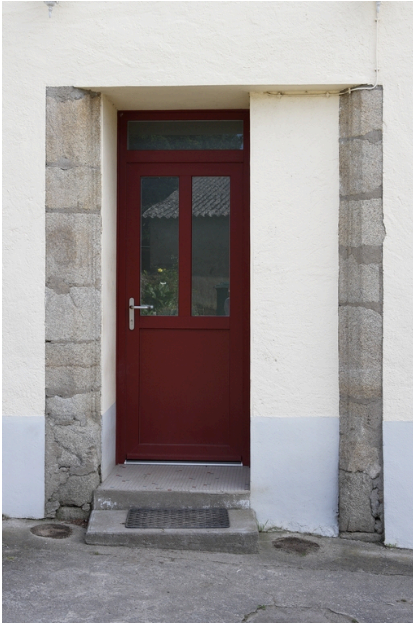
Logis. Partie ouest. Façade sud. Porte.
