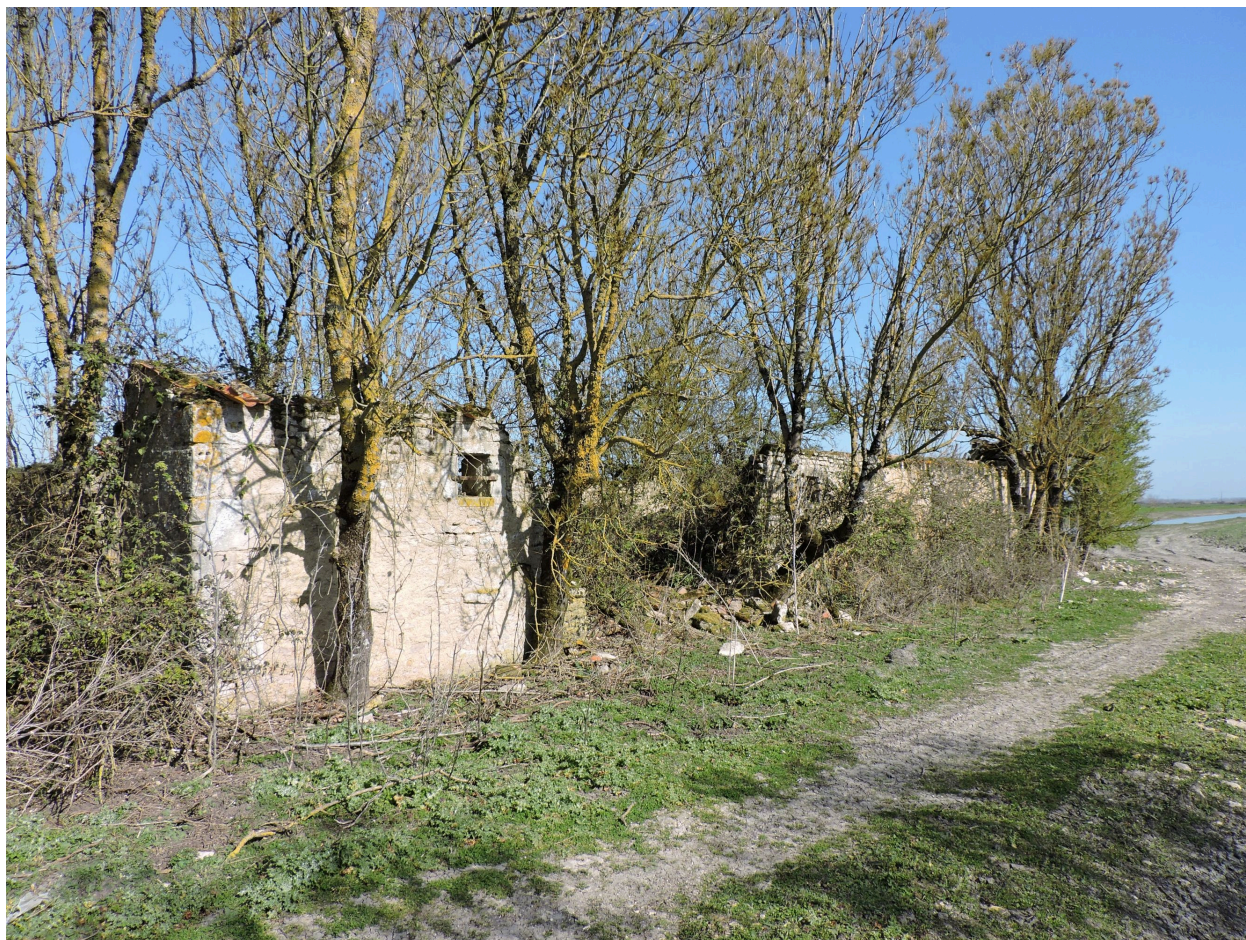
Les ruines de la grange-étable prolongeant le logis au nord-est, vues depuis le sud.
