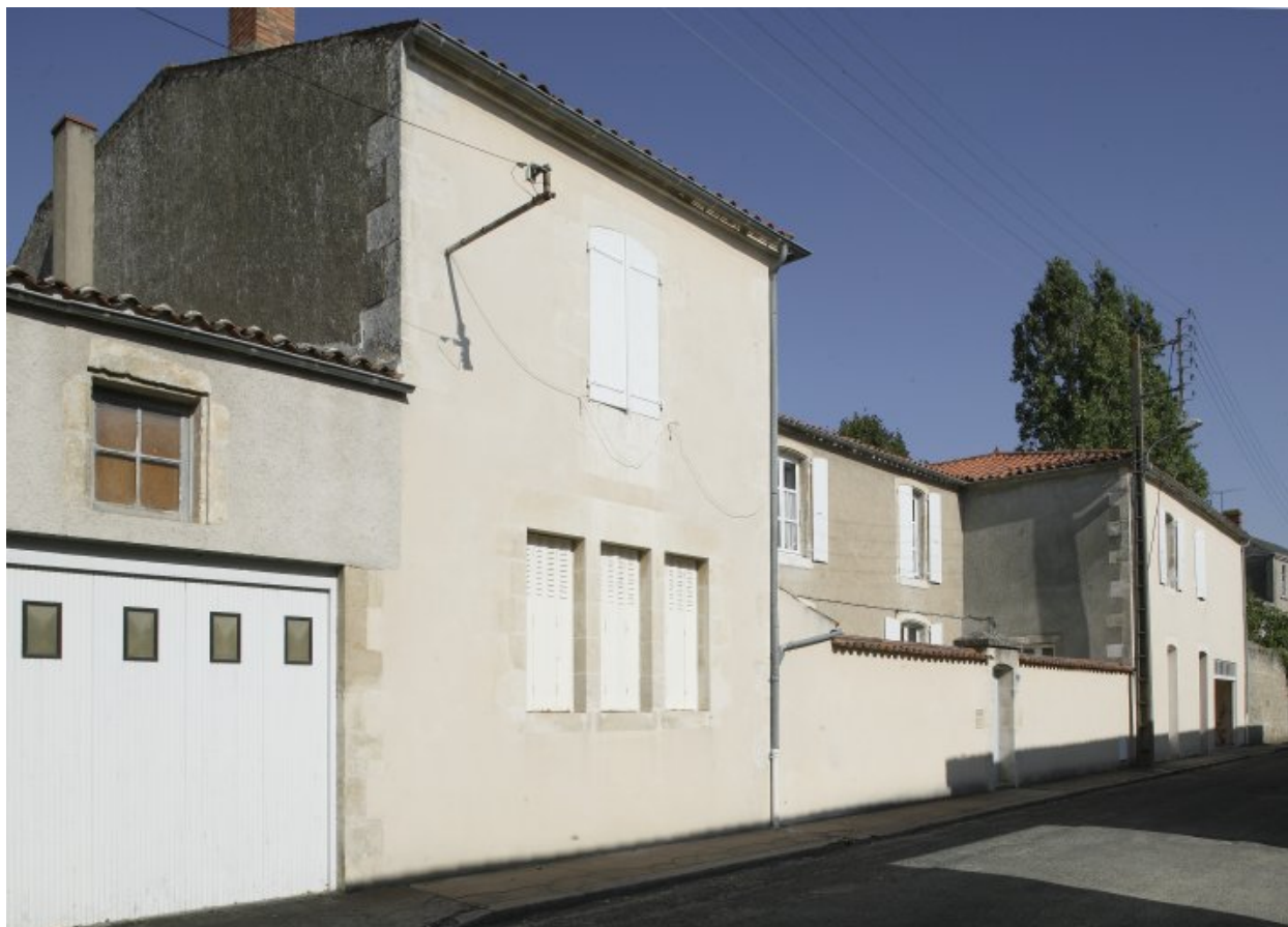
Vue d'ensemble prise du sud de la rue.
