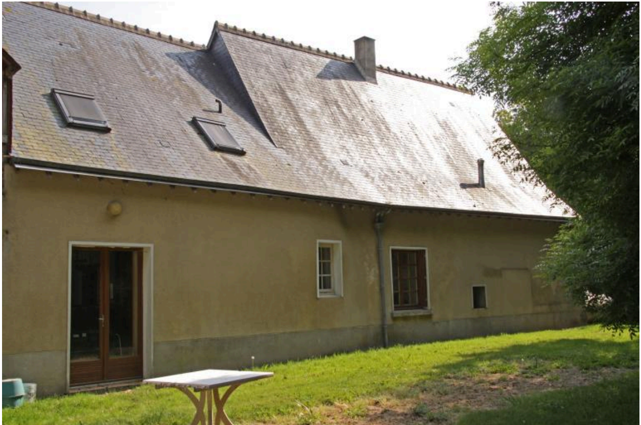
Maison : façade postérieure (vue partielle).
