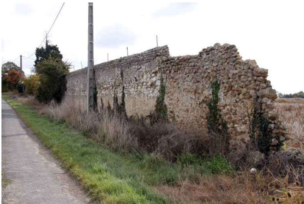
Le mur de clôture : façade externe.
