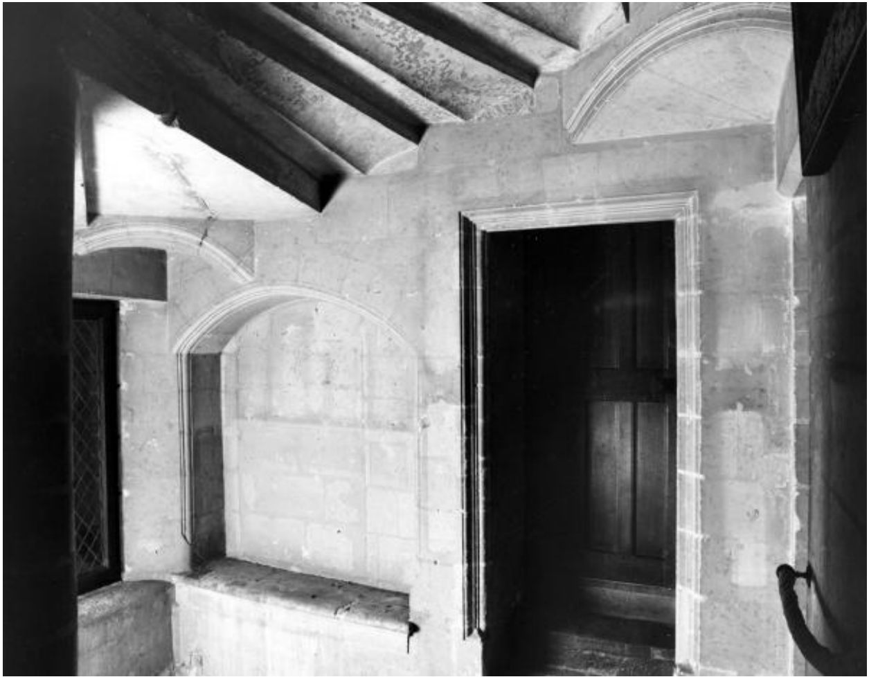
Cage de l'escalier, fin de la première révolution avec porte d'accès au corps de logis gauche (pièce postérieure du 2e niveau).
