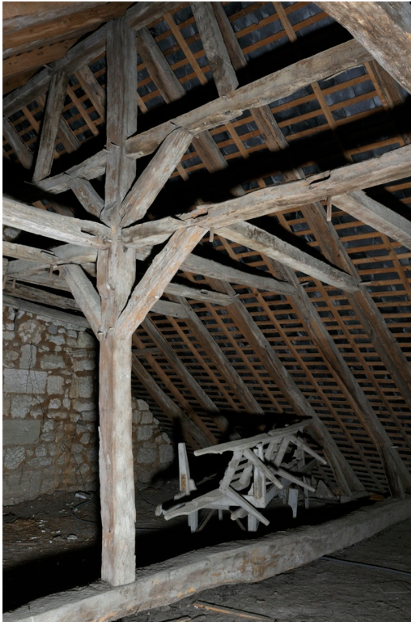
Comble. Charpente à chevrons porteurs (au-dessus de la grande salle). Ferme principale, fermes secondaires, contreventements.
