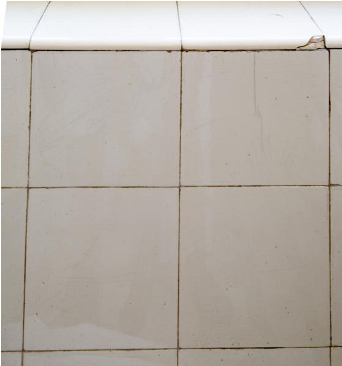
Vue des carreaux céramique dans la salle d'eau du premier étage.
