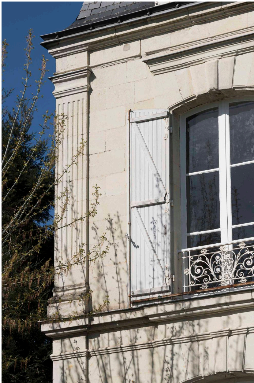
Détail de l'angle sud-est de la maison.
