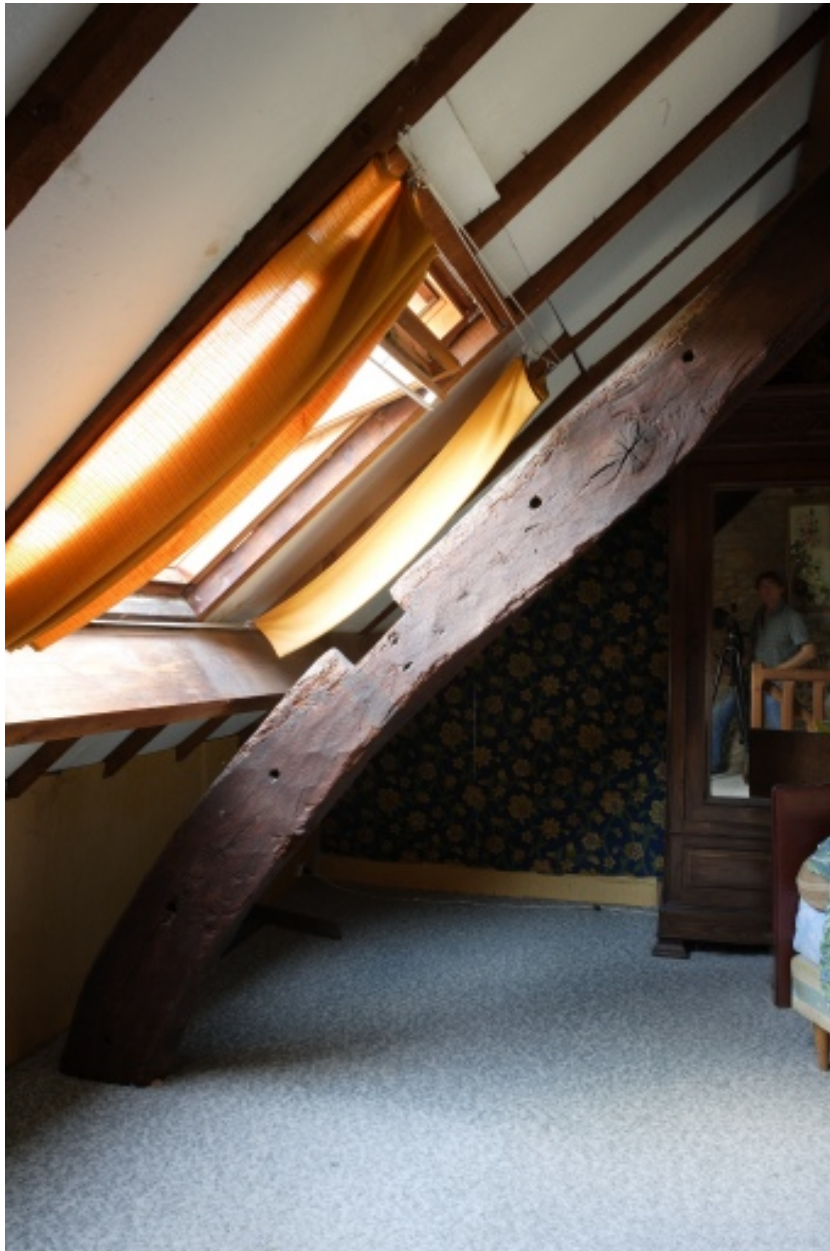
Détail d'un chevron-arbalétrier de la charpente (6 rue de l'Aha).
